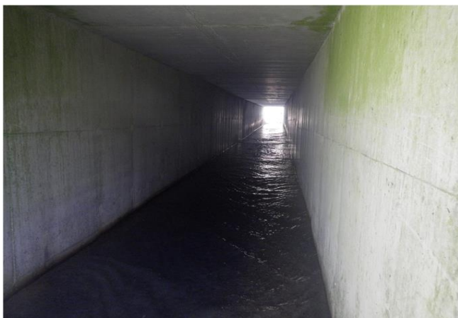
Foto gegen Fließrichtung
