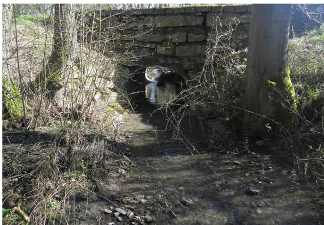
Foto gegen Fließrichtung
