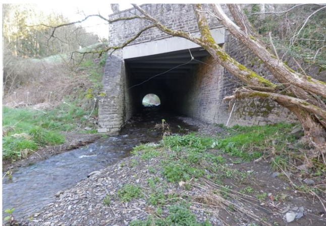
Foto gegen Fließrichtung
