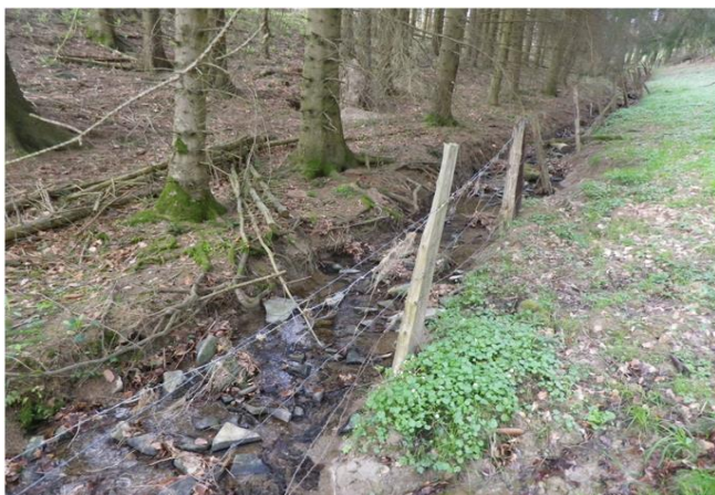
Foto gegen Fließrichtung
