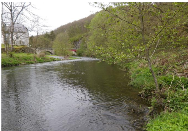
Foto gegen Fließrichtung
