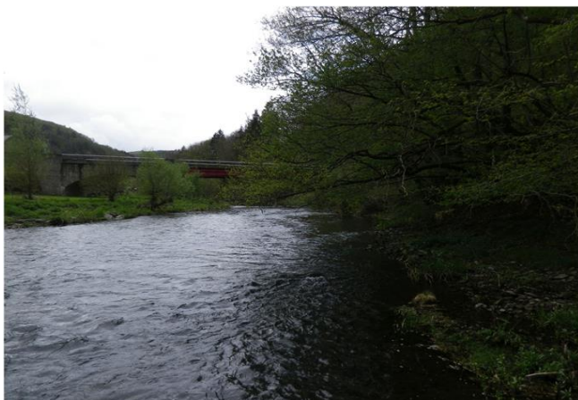
Foto gegen Fließrichtung
