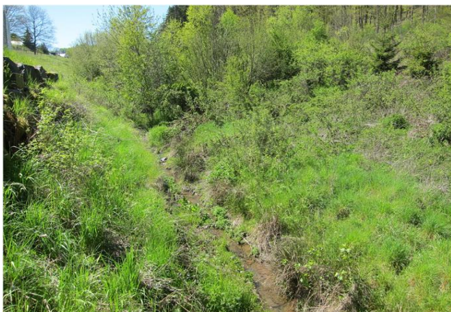
Foto gegen Fließrichtung
