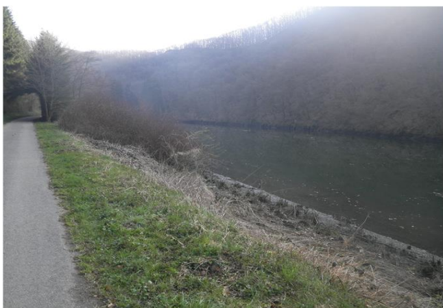
Foto gegen Fließrichtung
