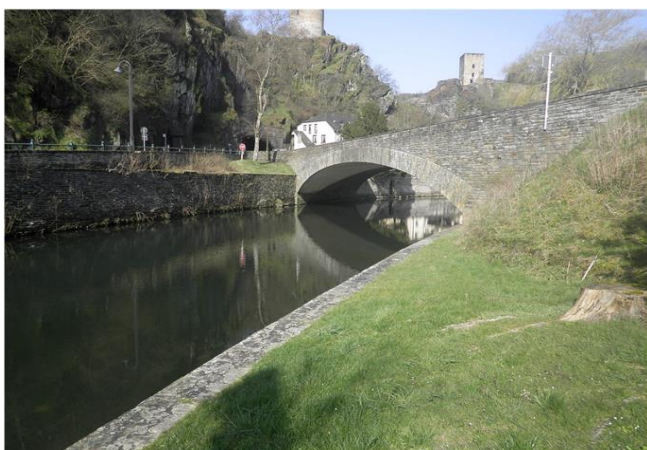
Foto gegen Fließrichtung
