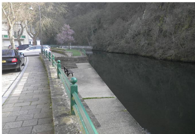
Foto gegen Fließrichtung
