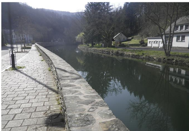
Foto gegen Fließrichtung
