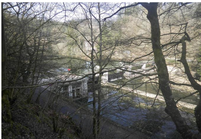
Foto gegen Fließrichtung
