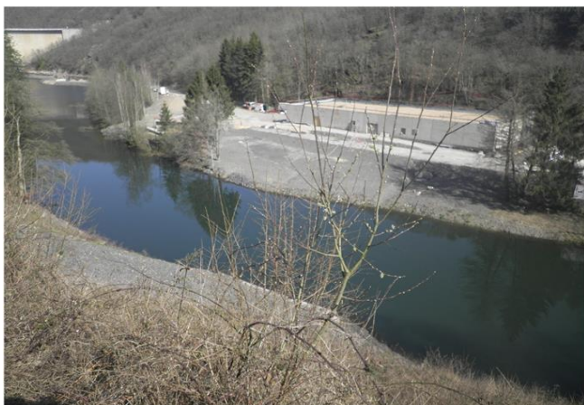
Foto gegen Fließrichtung
