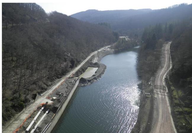
Foto gegen Fließrichtung
