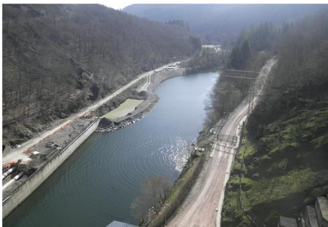
Foto gegen Fließrichtung
