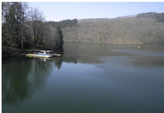
Foto gegen Fließrichtung
