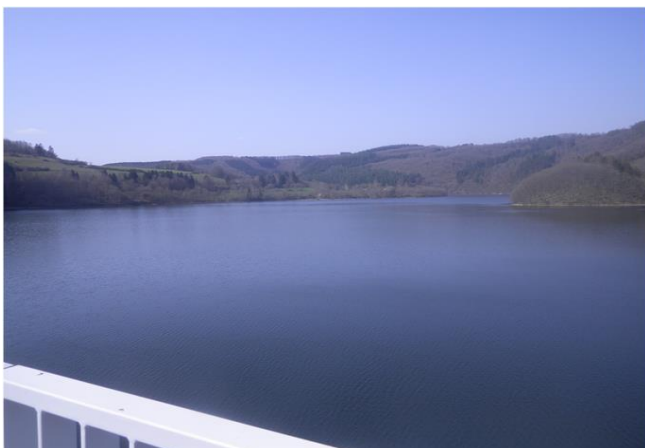
Foto gegen Fließrichtung
