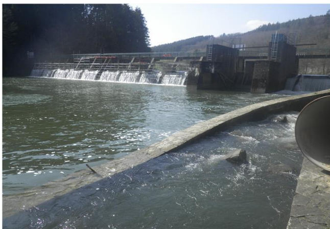
Foto gegen Fließrichtung
