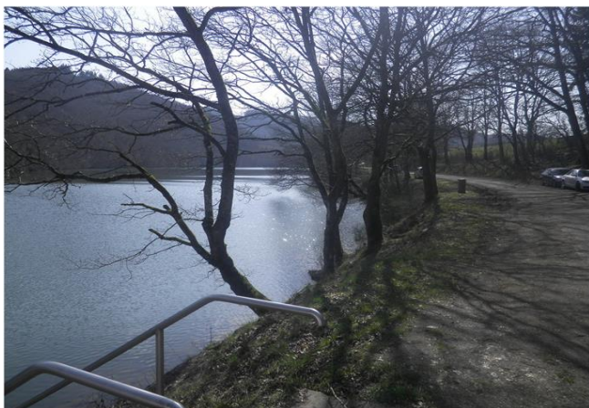
Foto gegen Fließrichtung
