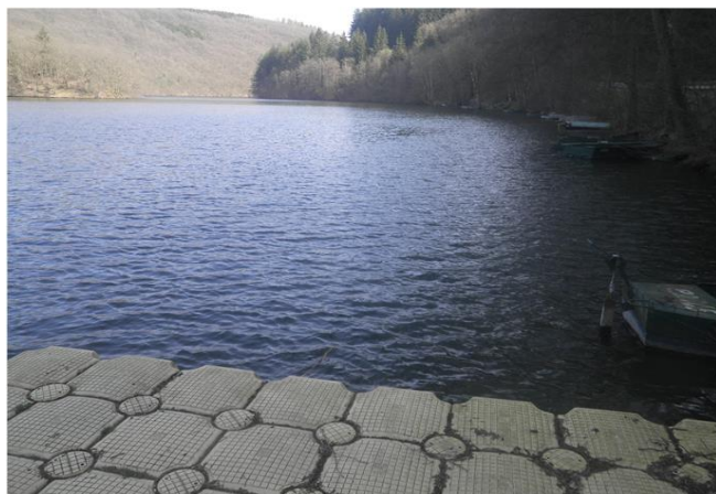
Foto gegen Fließrichtung
