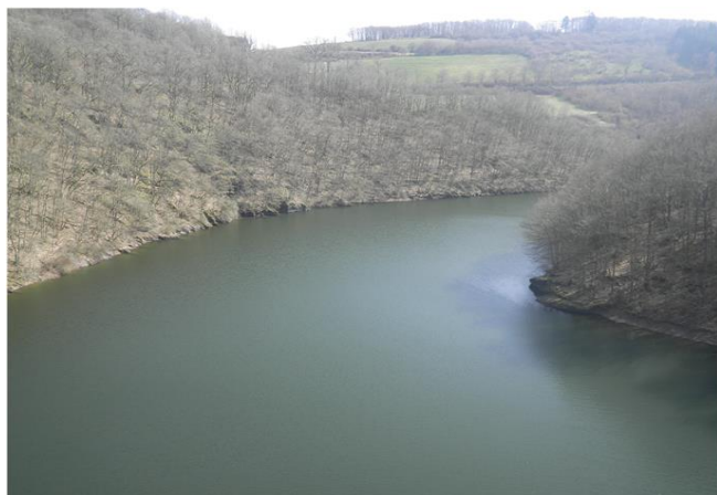
Foto gegen Fließrichtung
