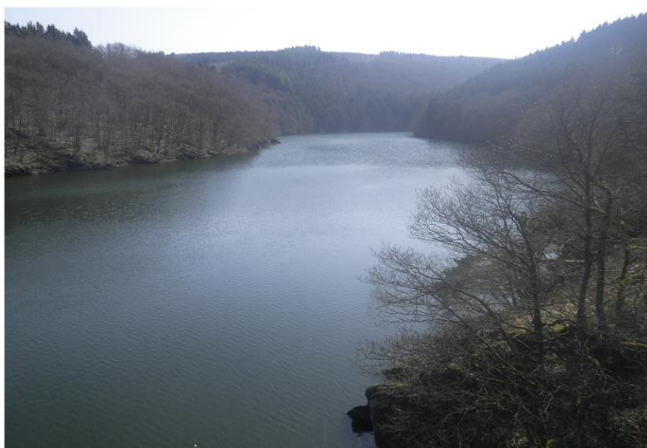
Foto gegen Fließrichtung
