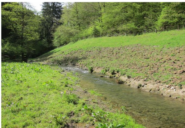
Foto gegen Fließrichtung
