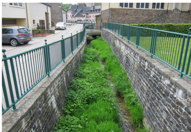
Foto gegen Fließrichtung
