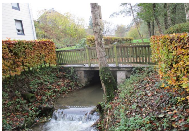
Foto gegen Fließrichtung
