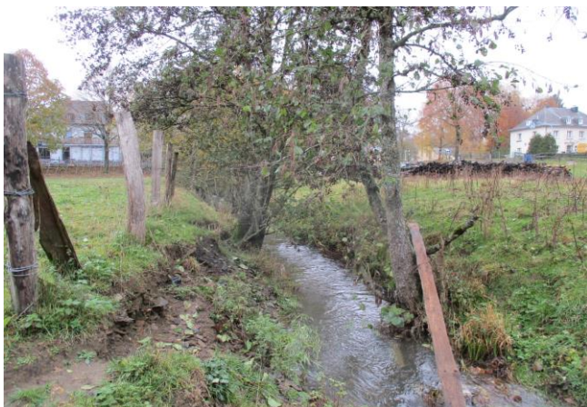
Foto gegen Fließrichtung
