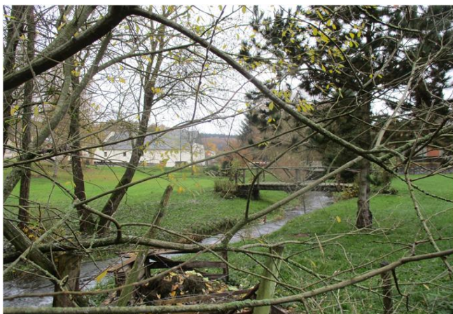
Foto gegen Fließrichtung
