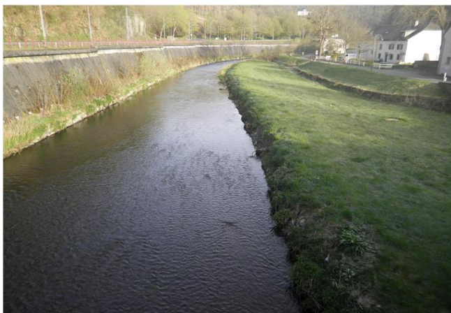
Foto gegen Fließrichtung
