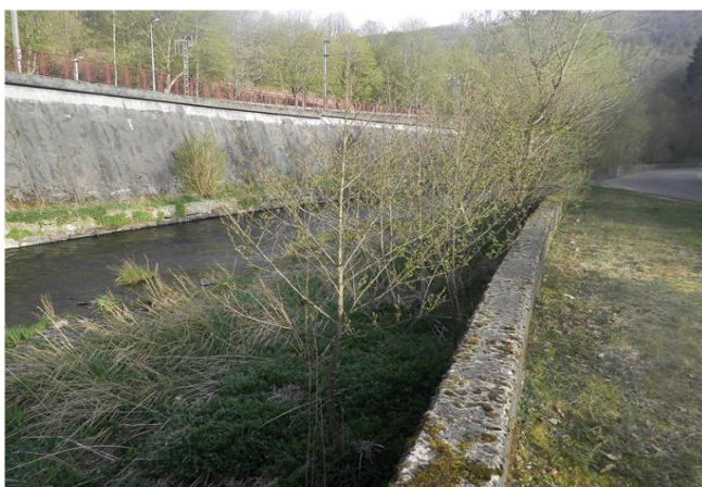
Foto gegen Fließrichtung
