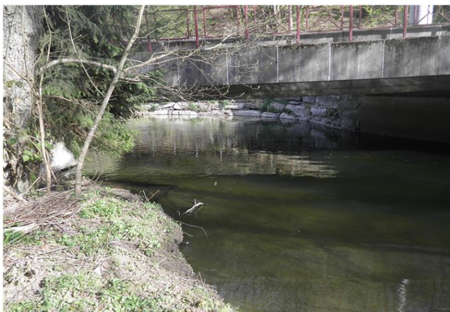
Foto gegen Fließrichtung
