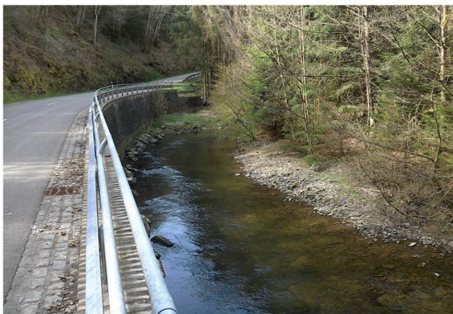
Foto gegen Fließrichtung
