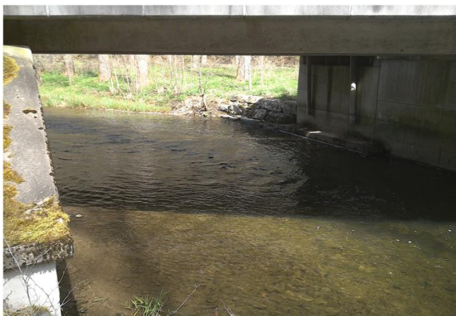
Foto gegen Fließrichtung
