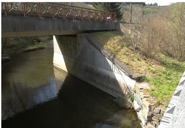
Foto gegen Fließrichtung
