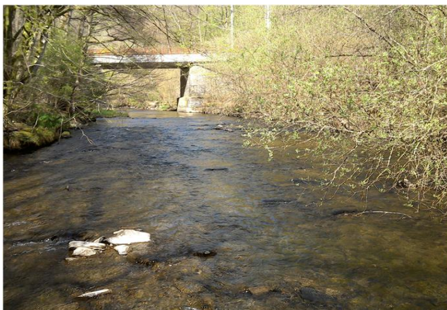
Foto gegen Fließrichtung
