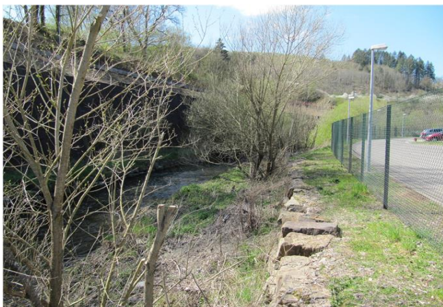
Foto gegen Fließrichtung
