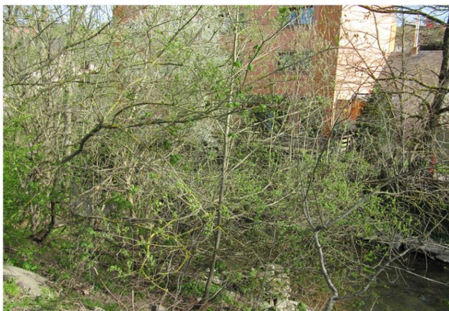
Foto gegen Fließrichtung
