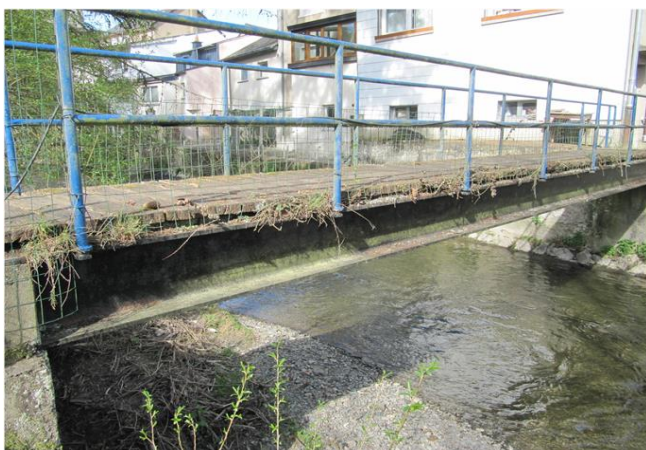
Foto gegen Fließrichtung
