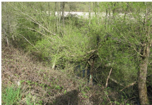
Foto gegen Fließrichtung
