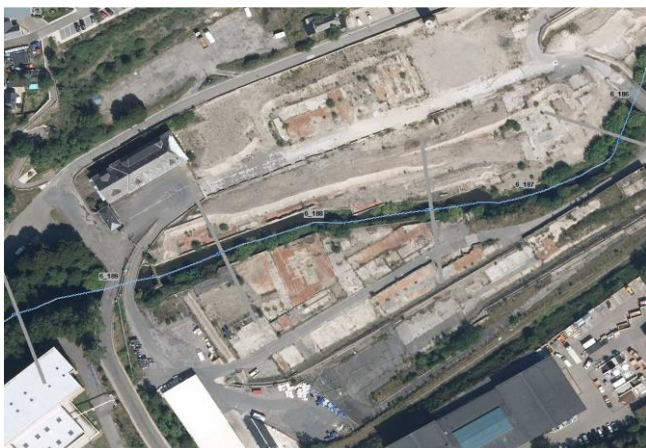
Foto gegen Fließrichtung
