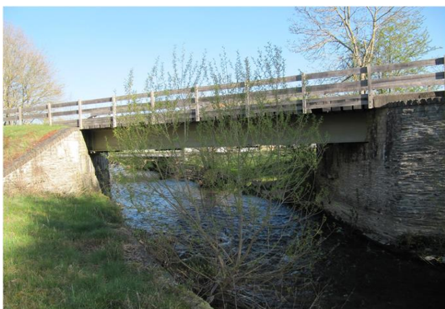
Foto gegen Fließrichtung
