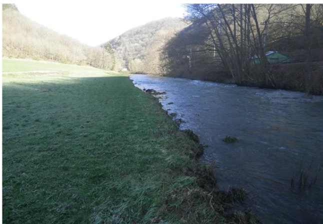
Foto gegen Fließrichtung
