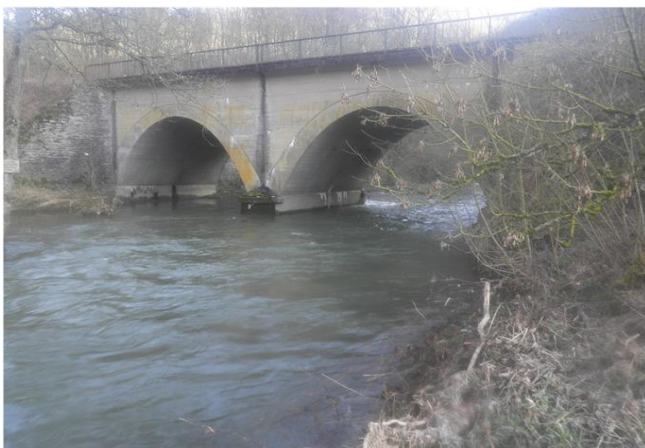
Foto gegen Fließrichtung
