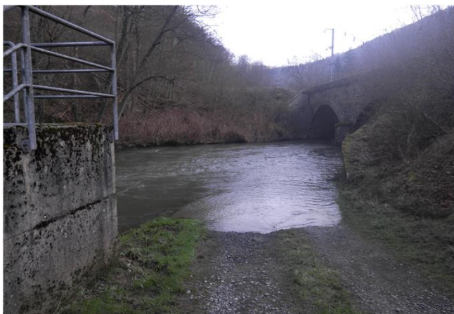
Foto gegen Fließrichtung
