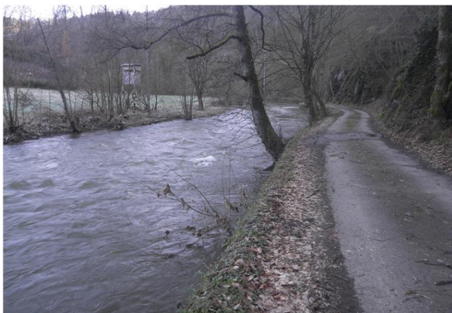
Foto gegen Fließrichtung
