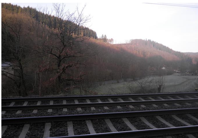
Foto gegen Fließrichtung
