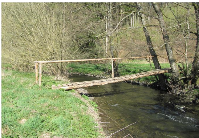
Foto gegen Fließrichtung
