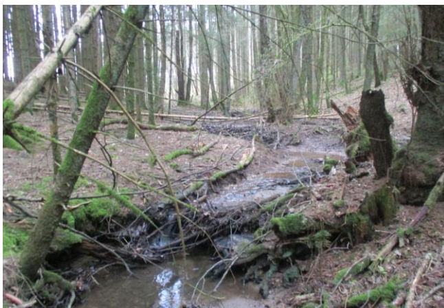
Foto gegen Fließrichtung
