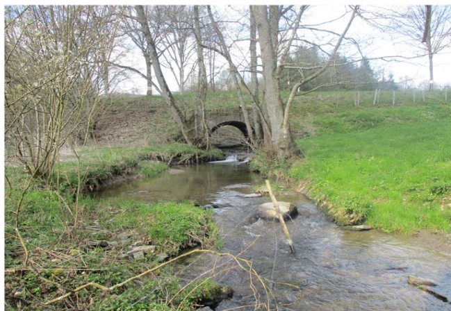
Foto gegen Fließrichtung
