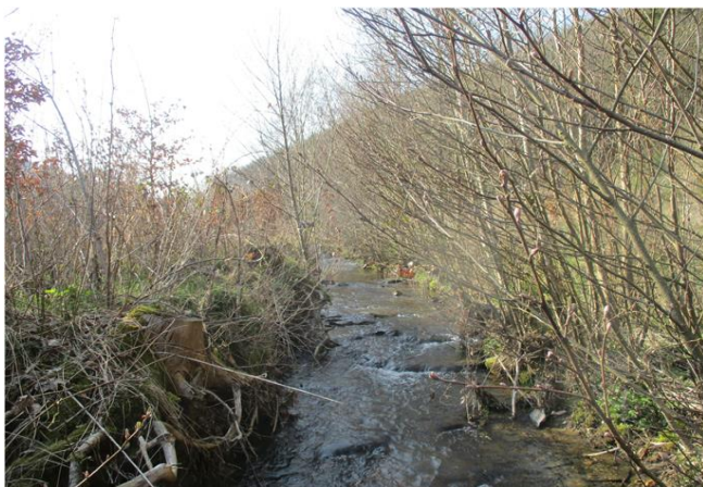
Foto gegen Fließrichtung
