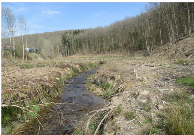
Foto gegen Fließrichtung
